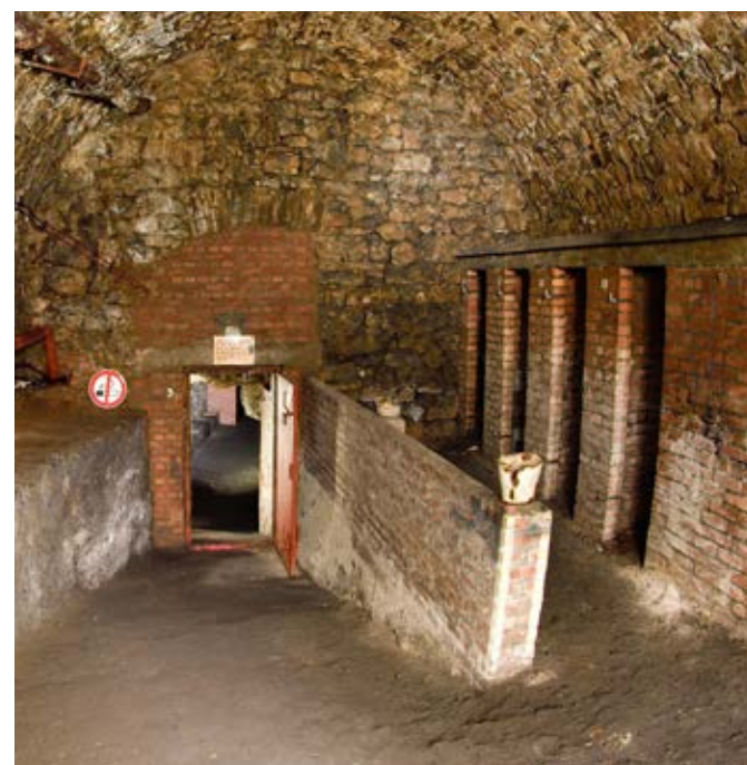
Toilettenhäuschen im Bunker Paradesstraße ©Klaus Stein
