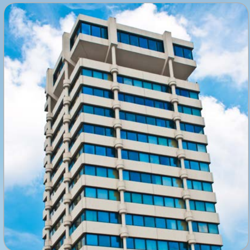
Sparkassenturm - von hier aus haben Sie einen tollen Blick auf das Tor der Stadt ©F. Schmitz
